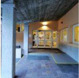
Ponte di Legno
